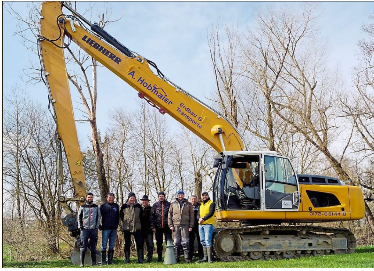
Für die Arbeiten in der Vils kam ein Spezialbagger zum Einsatz.
