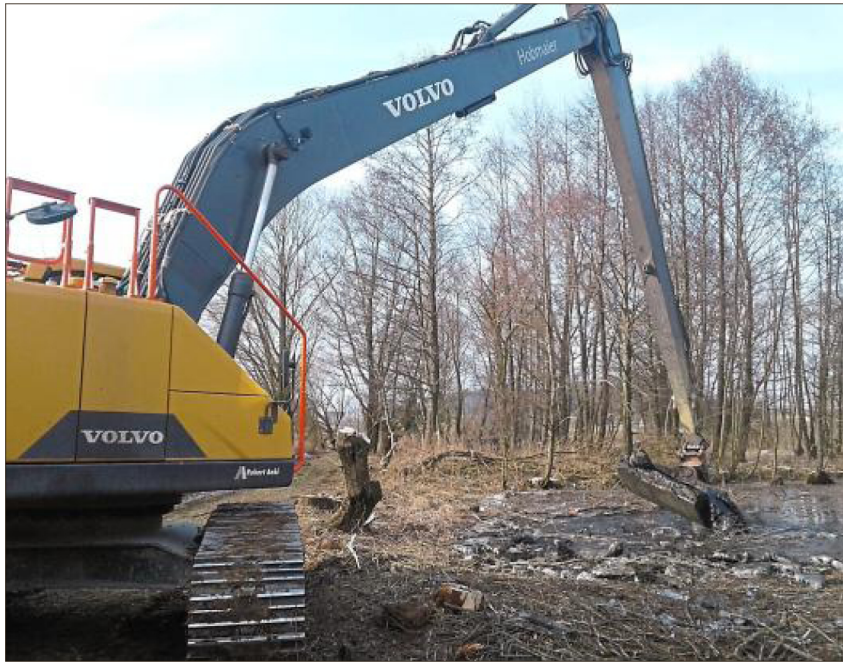
Das Biotop wurde entschlammt und ausgebaggert.
