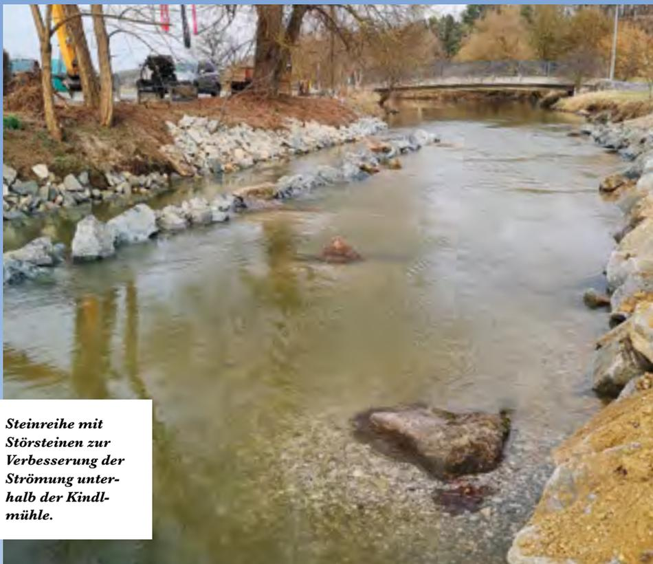
Steinreihe mit Störsteinen zur Verbesserung der Strömung unterhalb der Kindlmühle.
